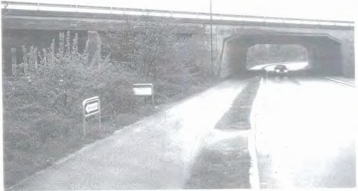
Kongsvang. Her ses den officielle adgang til stationen. Skiltet midt i billedet står ved passagen fra cykelstien til perronen.
